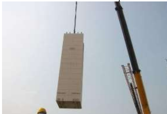
Fig. 1 Hoisting of precast columns
